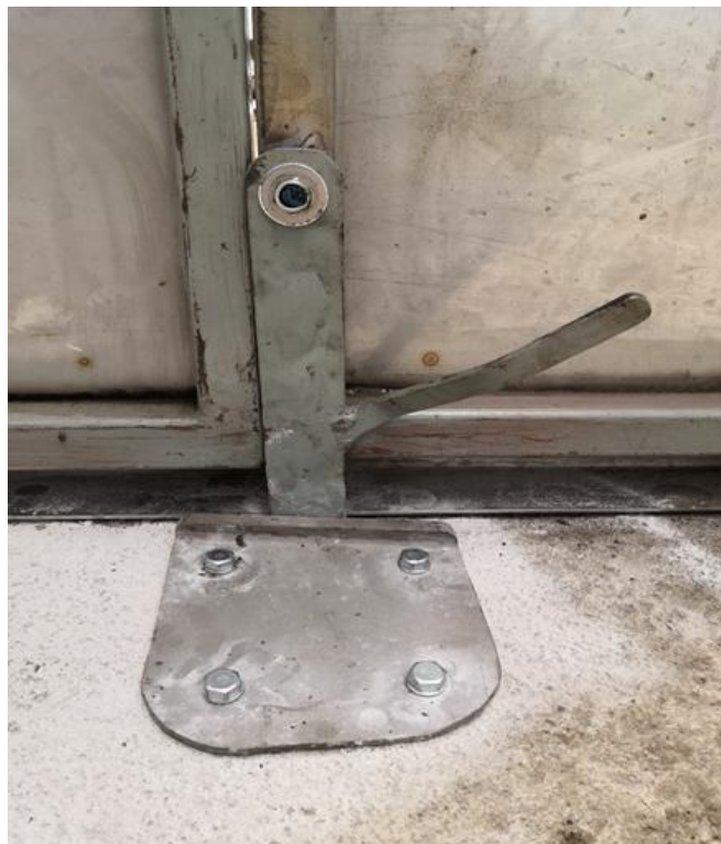
Εικόνα 4.27: Σύστημα κλείστρου-κεκλιμένης πλάκας για την ασφαλή της ανοξείδωτης πόρτας.
