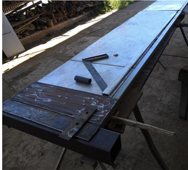
Εικόνα 4.23: Κοπή και διαμόρφωση τμημάτων πόρτας
