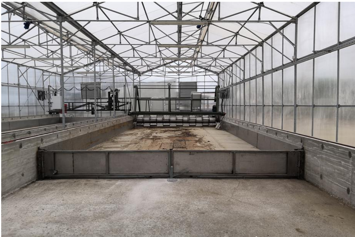
Εικόνα 4.28: Δημιουργία στεγανής ανοξείδωτης πόρτας.
