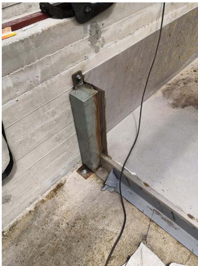
Εικόνα 4.21: Προσθήκη κοιλοδοκού για τη στήριξη της πόρτας
