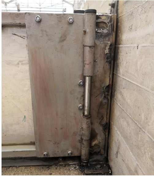
Εικόνα 4.26: Μέρος στεγανής ανοξείδωτης πόρτας με τους πείρους συγκράτησης.
