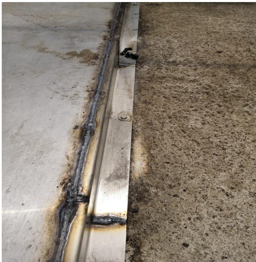
Εικόνα 4.20: Προσθήκη ελάσματος στεγανοποίησης κατά των διαρροών
