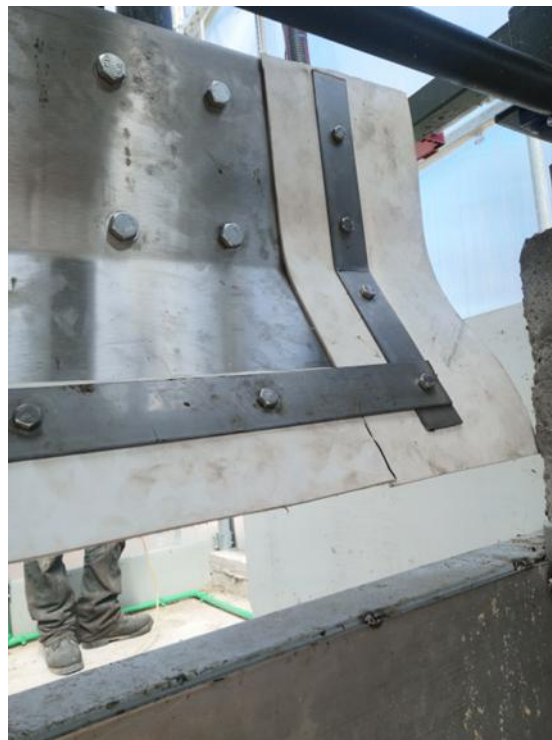
Εικόνα 4.34: Τοποθέτηση ιμάντα πολυουρεθάνης (PU) για την αποφυγή επαφής των μεταξύ μετάλλων.
