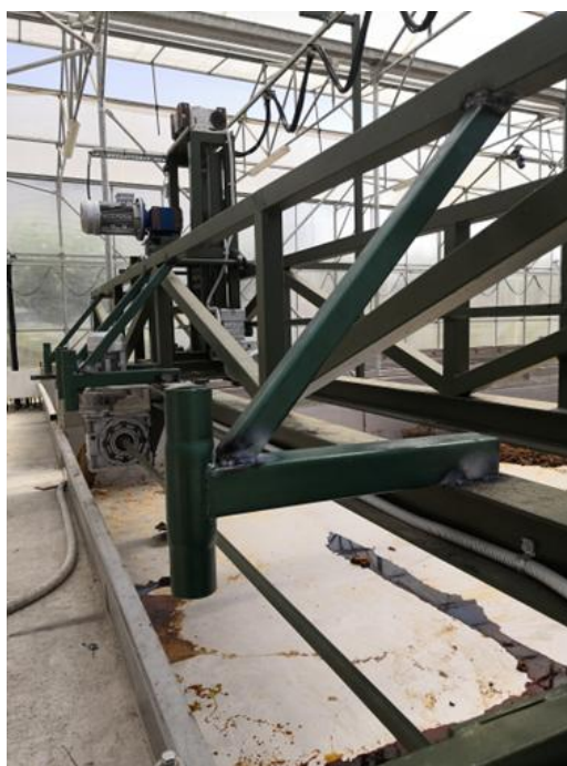
Εικόνα 4.37: Συγκόλληση κυκλοδοκού κάθετα με τη χαλύβδινη σωλήνα για στήριξη του ξέστρου.
