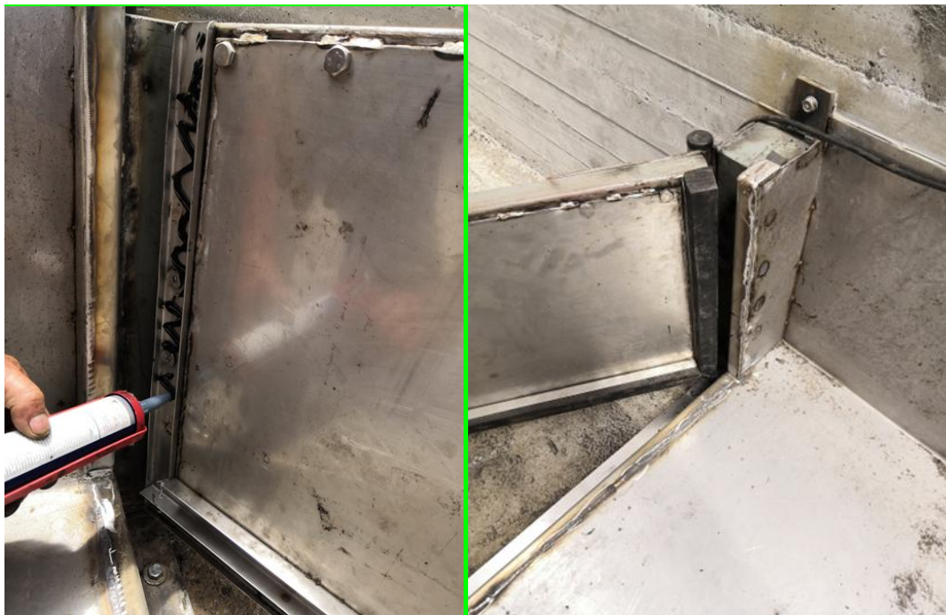
Εικόνα 4.24: Στεγανοποίηση ανοξείδωτης πόρτας.
