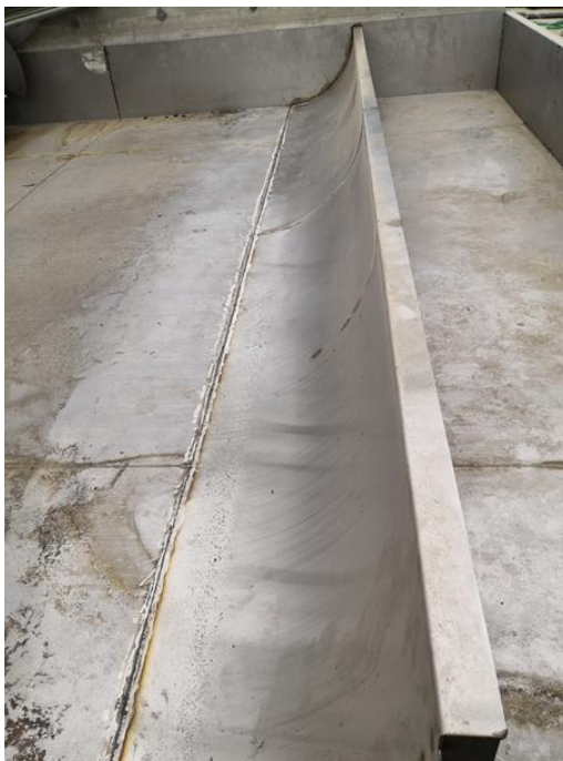
Εικόνα 4.32: Κοίλη ανοξείδωτη κατασκευή στο οριζόντιο σύστημα ανάδευσης.
