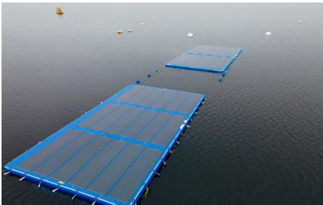
Εικόνα 2-8: 20KW σύστημα της εταιρείας Bluewater στο Oostvoornse Meer.
