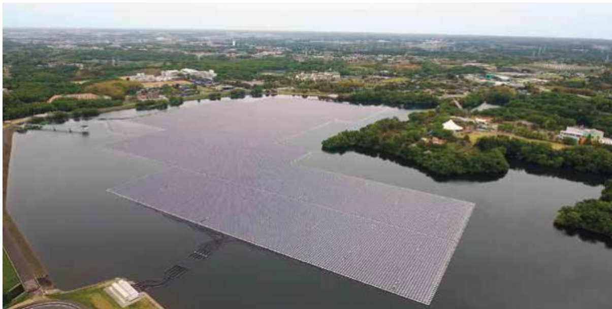
Εικόνα 2-2: Πλωτή ΦΒ εγκατάσταση στην Ιαπωνία.
