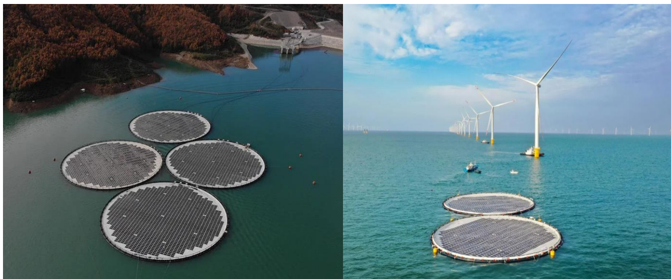
Εικόνα 2-12: α) 2MW Σύστημα στην Αλβανία, β) 500KW Σύστημα ενσωματωμένο σε υπεράκτια Α/Γ στην Κίνα.
