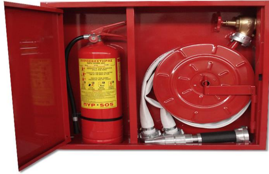
Εικόνα 7 Πυροσβεστική φωλιά.
