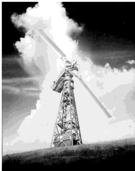
Εικόνα 3. Η ανεμογεννήτρια Smith-Putnam (ΗΠΑ, 1941), η πρώτη μεγάλης ισχύος που συνδέθηκε στο ηλεκτρικό δίκτυο.
